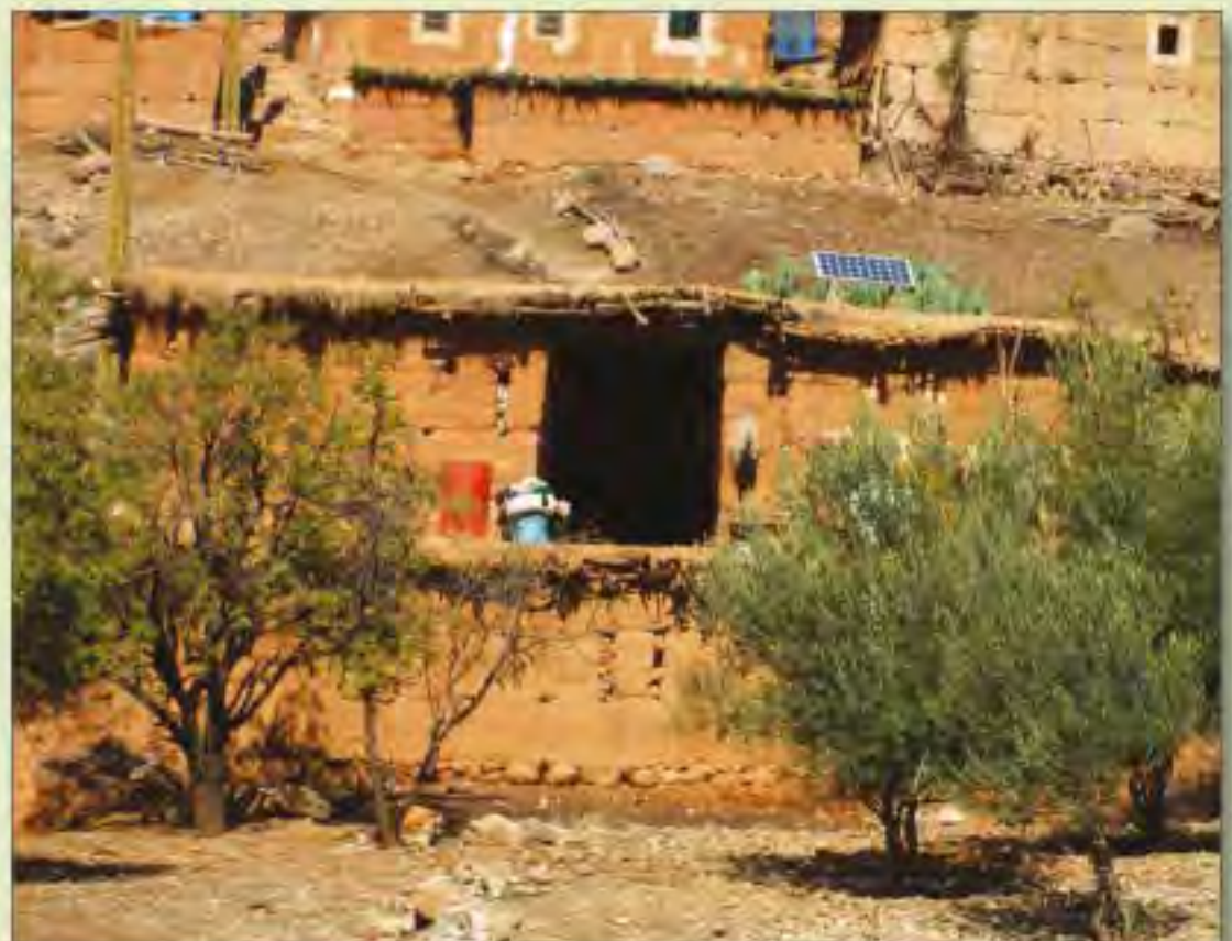
Panneau solaire sur les toits, Haut-Atlas, Maroc. 2008.
